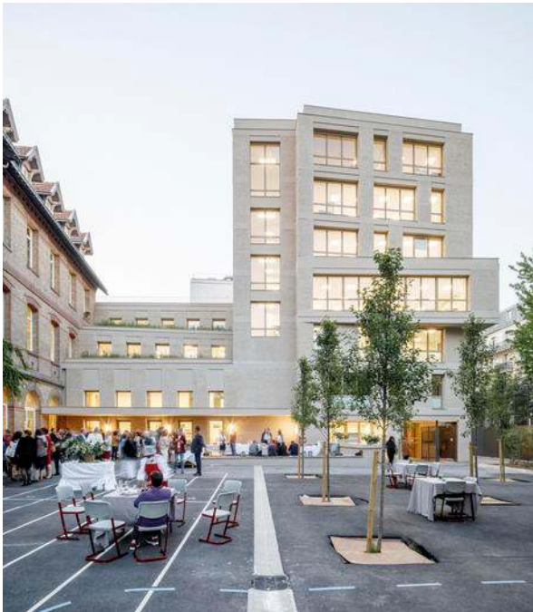
Nouveau bâtiment lycée, vue cour, en lien avec le lycée historique
